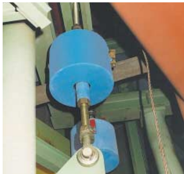
Support variable type 22 avec chape taraudée montée.
